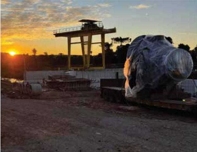
Durante o mês de julho, a PCH Santo Antônio do Jacuí recebeu quatro turbinas Kaplan Bulbo, cada uma com 28,5 toneladas e 1,3 MW de potência. A instalação destes equipamentos é uma das fases mais importantes da construção, pois as turbinas são o “coração” da usina, que convertem a força da água em energia.
