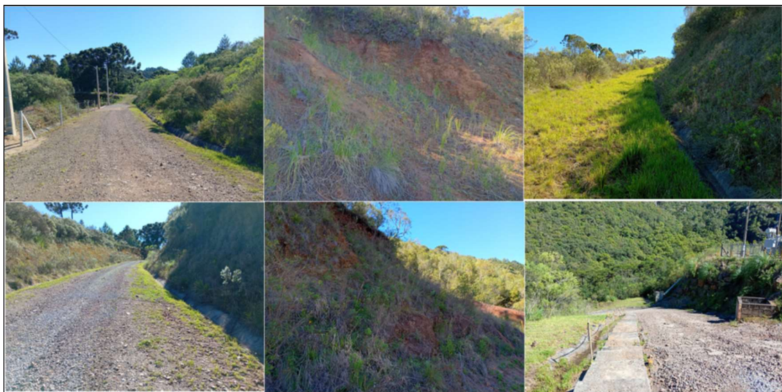
FONTE: Setor de Meio Ambiente – CAZUZA FERREIRA ENERGÉTICA
