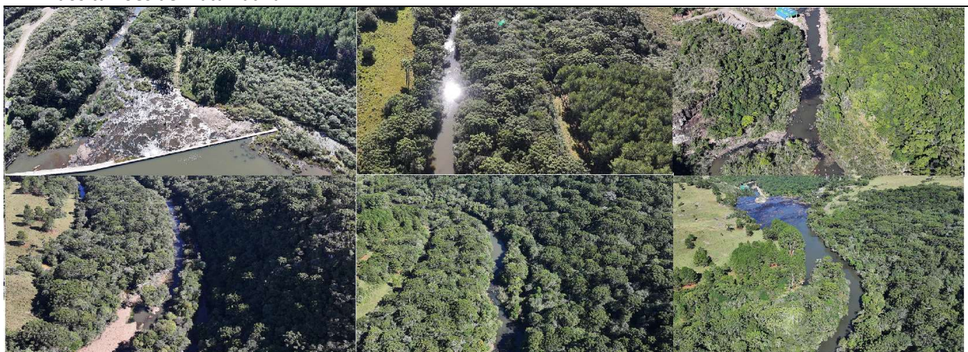
FONTE: Setor de Meio Ambiente – CAZUZA FERREIRA ENERGÉTICA
